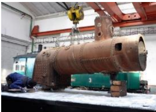
Kotel před odvozem do opravy
