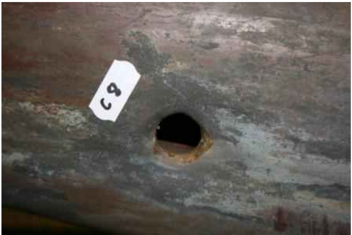
Deformace pláště po vylomeném ramínku.
