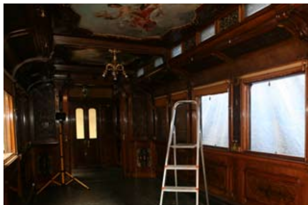
Interiér císařského jídelního vozu během restaurování
